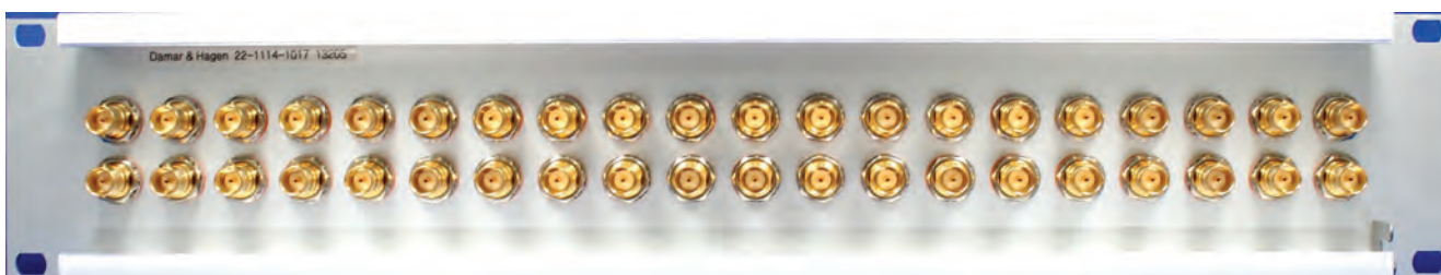
Abb. Steckfeld 22-1114-1017 mit orangenen Isolierdurchführungen
