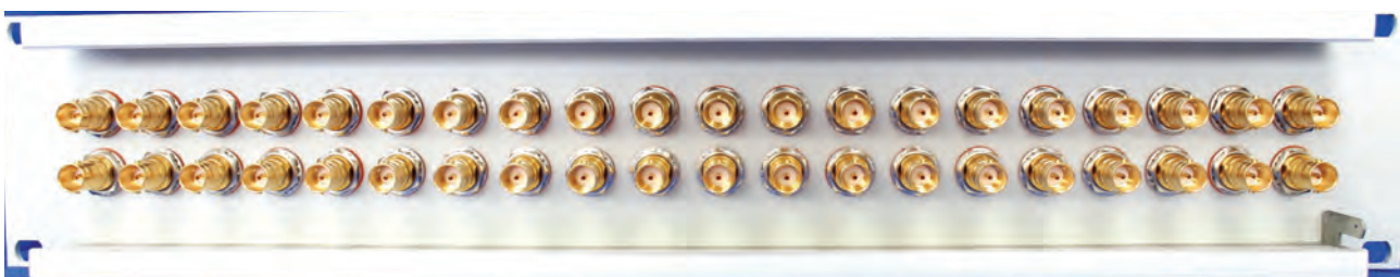
Abb. Steckfeld 22-1126-1017 mit orangenen Isolierdurchführungen
